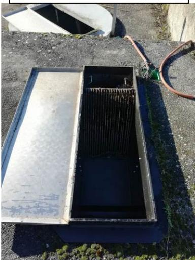
Chasse à clapet n°1 avec compteur de bâchée
